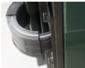
Cerniera a scomparsa in acciaio
